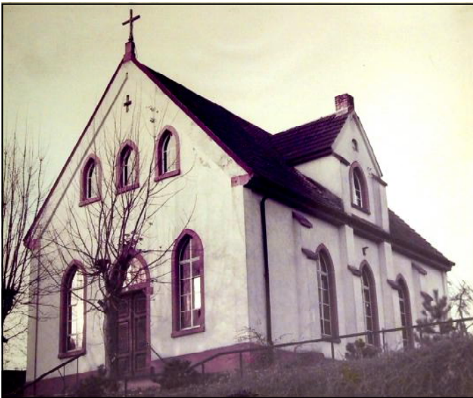
Die Kapelle der Baptisten, erbaut 1892 in der Vörstetter Straße, 1985 abgerissen
